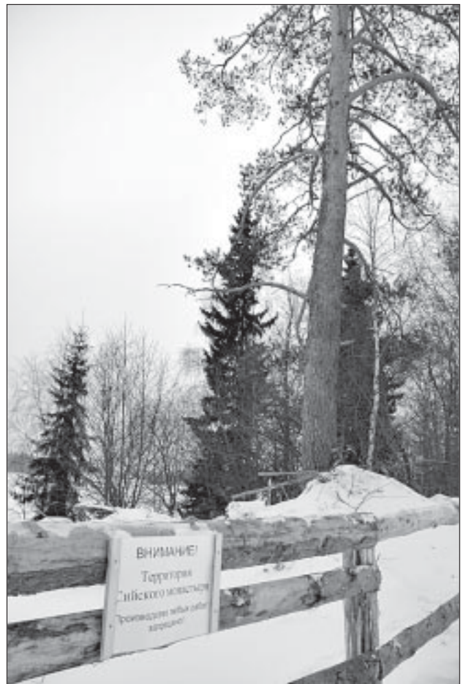
На снимках: от стройплощадки до монастыря — рукой подать; техника не щадит заповедное озеро; обследование территории стройки; наша граница «на замке».
